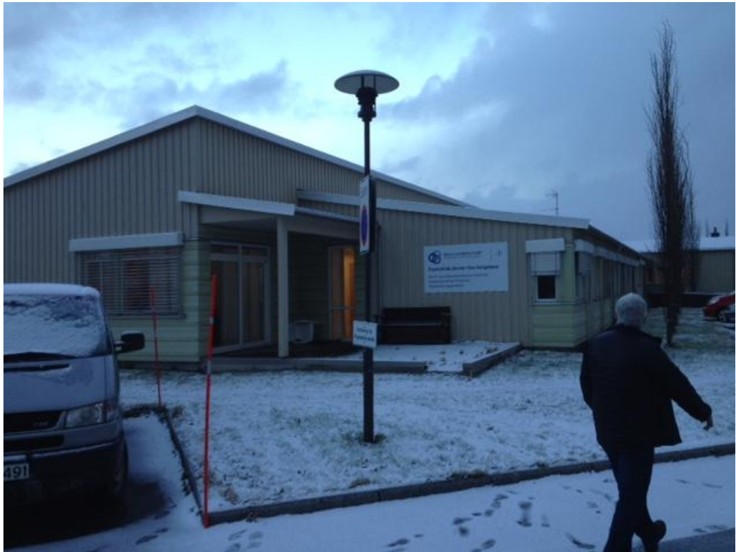
Figur 12: Brønnøysund DPS, bilde fra nord
