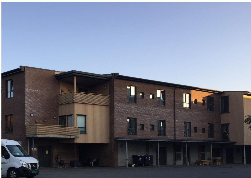
Område for utvidelse av tekniske rom i eksisterende bygg
